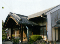
移築前の本堂（顕照山高岳寺）
